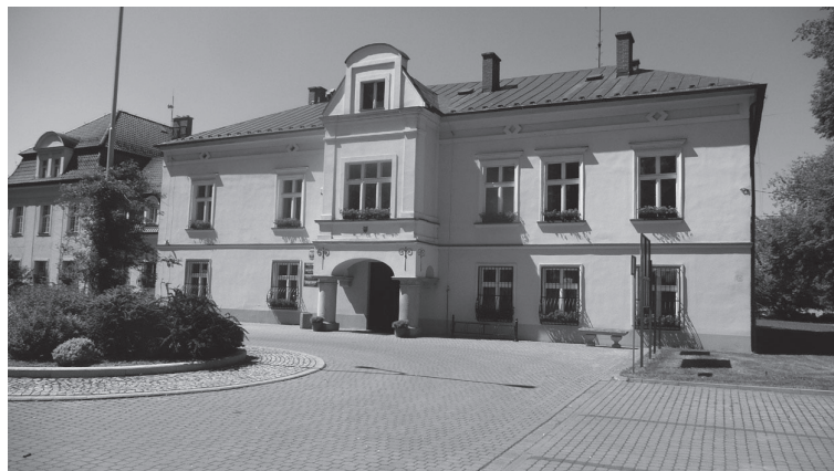
Główna, południowa, fasada pałacu wzniesionego w XVIII wieku; stan z 2016 roku. Fot. Autora
