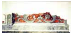
Odkryty fragment polichromii elewacji wschodniej skrzydła zachodniego z ok. 1600 r.
