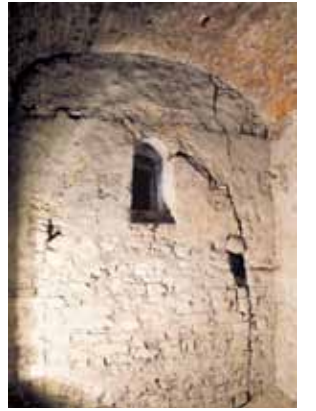
Wnętrze wieży zamkowej z widocznym zamurowanym portalem XIV-wiecznej bramy miejskiej
